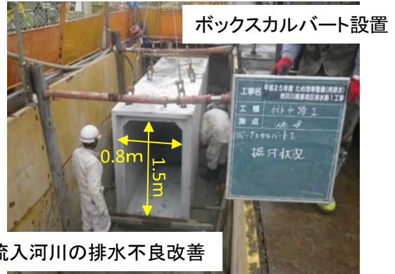
拡幅改修による排水能力の増加
