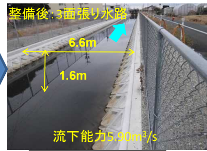
米津排水路 整備後
