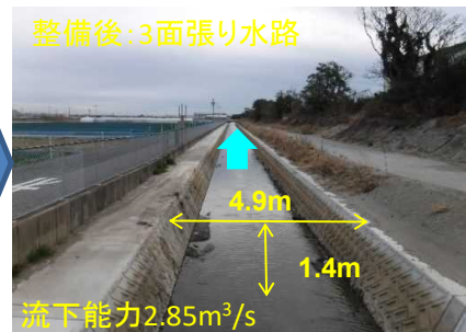
屋島川 整備後
