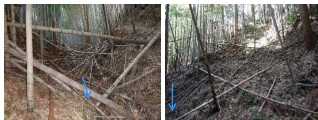
砂防堰堤施工箇所の状況(砂防堰堤正面を望む)
