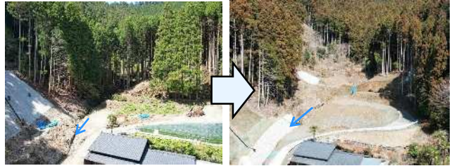
砂防堰堤の施工状況(堰堤掘削箇所を望む)
