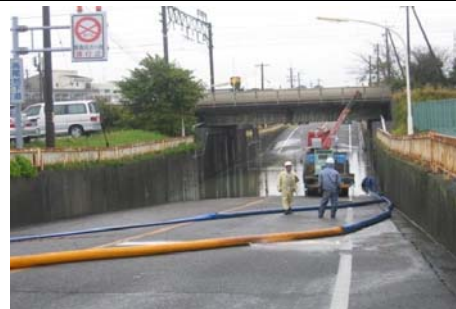
②H16.11浸水状況(袋井市内)
