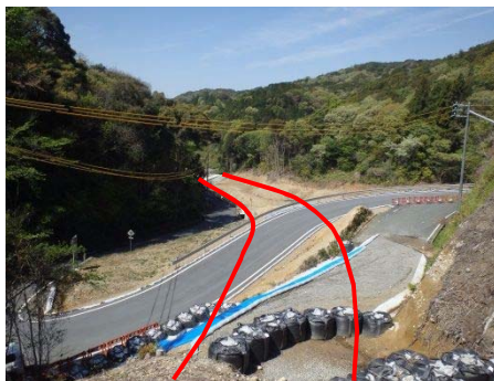
中間点から起点を望む
