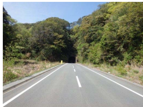
終点から起点を望む
