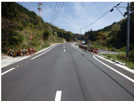
起点から終点を望む
