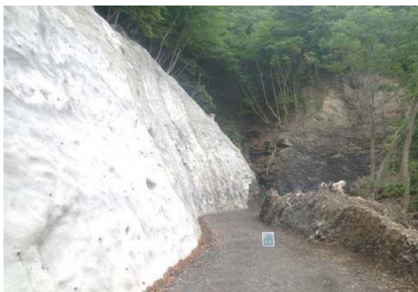
⑤林道の開設状況
