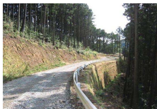
⑥コスト縮減(補強土壁工採用)
