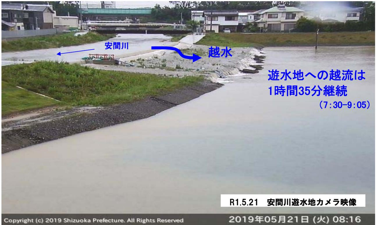
令和元年5月21日の豪雨は、氾濫危険水位を超過した平成24年8月豪雨(82mm)以上の総雨量127mmを記録したが、洪水を遊水地に貯めたことにより、河川水位が上昇せず、遊水地の整備効果が発揮された。
