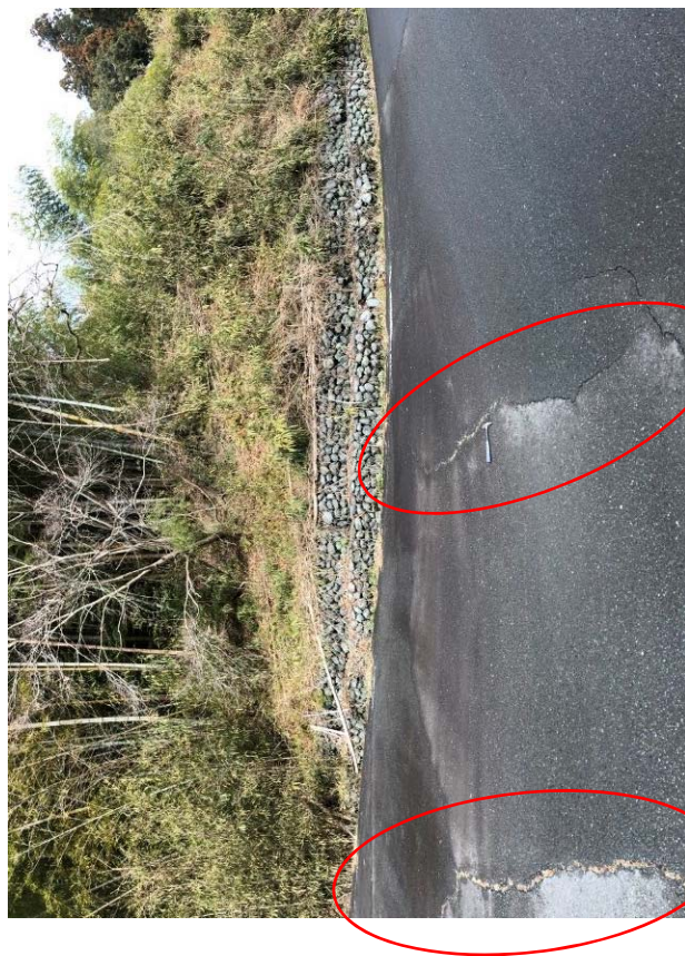
①路面上の開口亀裂
