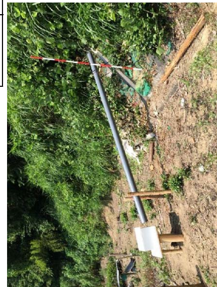
②滑落崖（地盤伸縮計設置）
