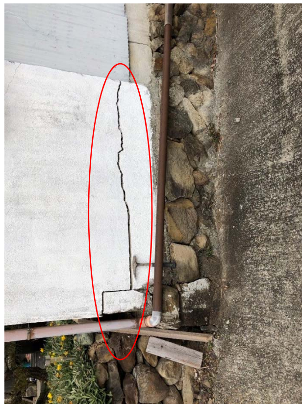
①路面上の開口亀裂
