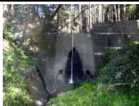
計画堰堤 (既設治山堰堤腹付補強)
