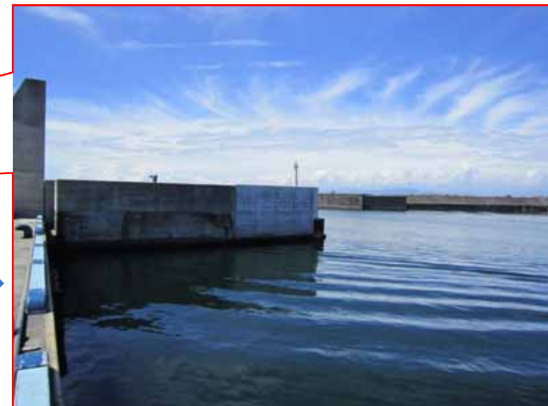
整備後の状況
