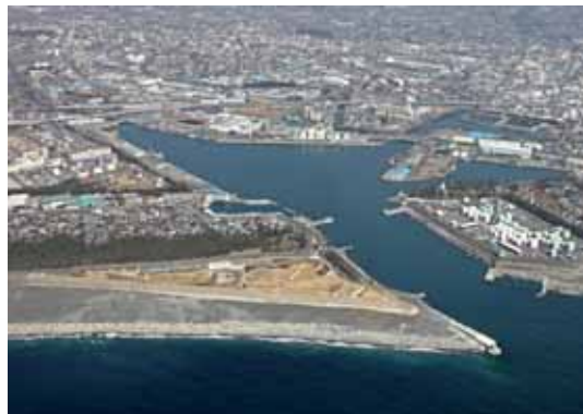
整備後の状況
