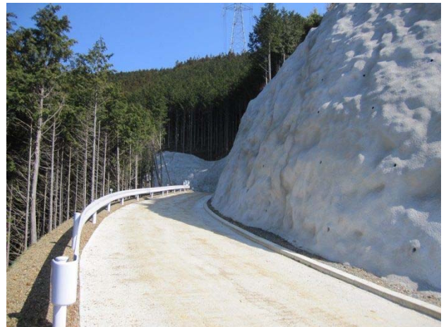
⑩3工区 施工状況(モルタル吹付)
