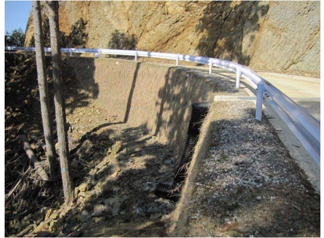
⑧3工区 コスト縮減(補強土壁工)
