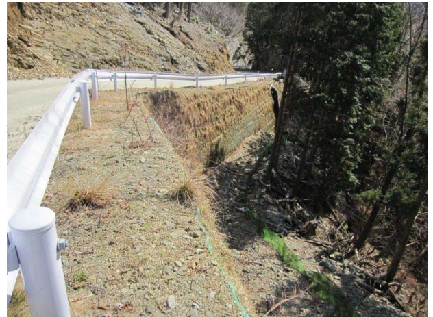
④2工区 コスト縮減(補強土壁工)
