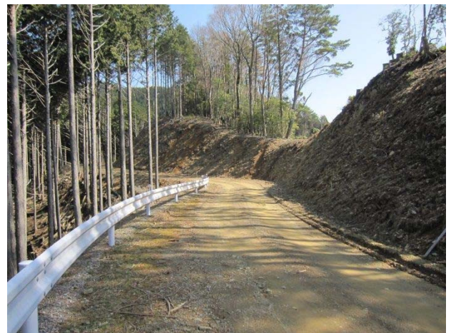
⑥3工区 開設状況1
