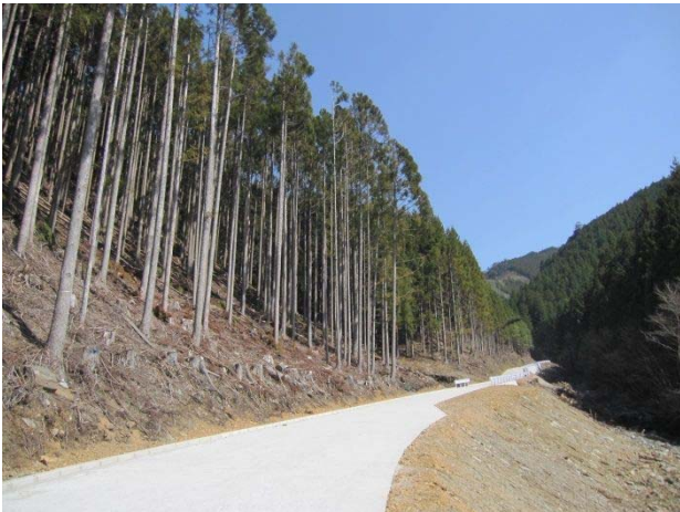
③1工区 開設状況1
