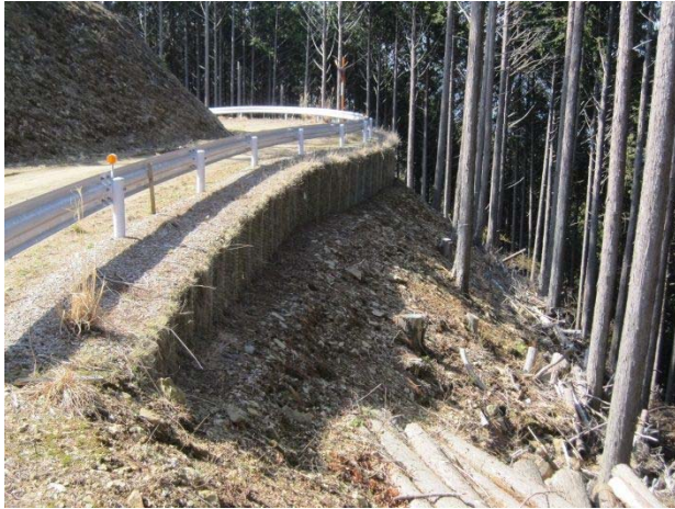
⑦23工区 コスト縮減(鋼製L型)
