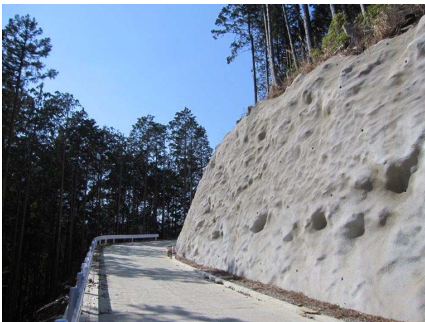
⑤2工区 施工状況(モルタル吹付)
