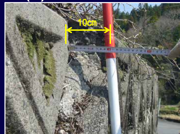
道路の山留擁壁が10cm押し出される
