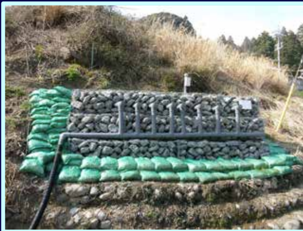
写真-1 横ボーリング工外景
