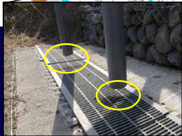
横ボーリング工の集水状況
