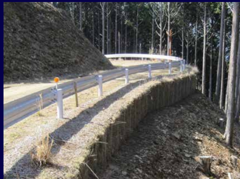
鋼製L型擁壁工の採用
