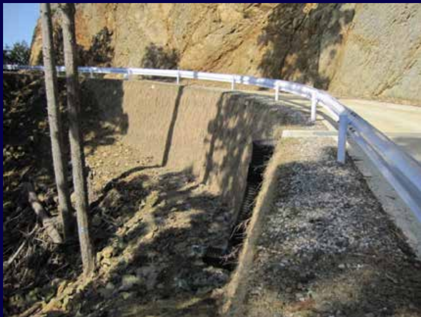
補強土壁工の採用
