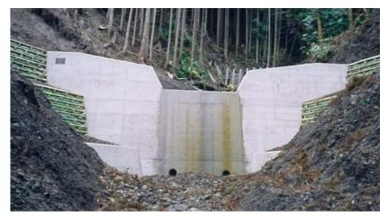
谷止工により、上流からの土砂流 出を抑制するとともに、渓床勾配を 緩和し、縦侵食及び横侵食を防ぎ 山が崩れにくくなる。
