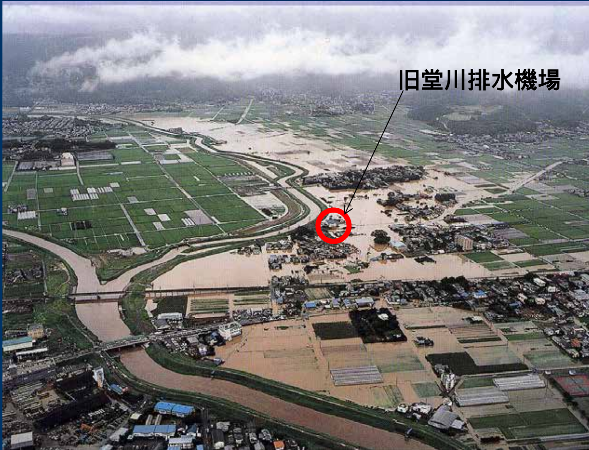
柿沢川周辺の湛水被害状況(H10.8)
