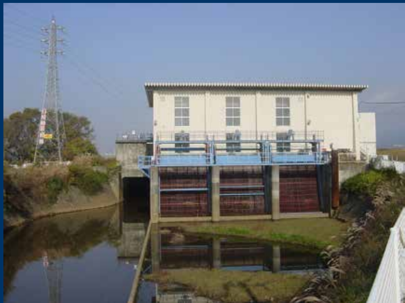
旧堂川排水機場外観
