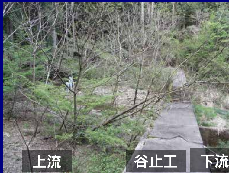
現状 谷止工上流の土砂が安定
