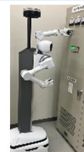
ロボットによるリモート 設備検査
