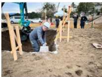
手元作業員が多い現場
