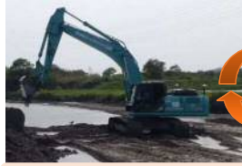
ICTによる計測・管理
