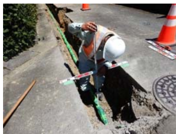
従来手法による埋設深さの計測
