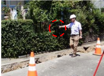
B GNSSを用いた写真測量技術①
