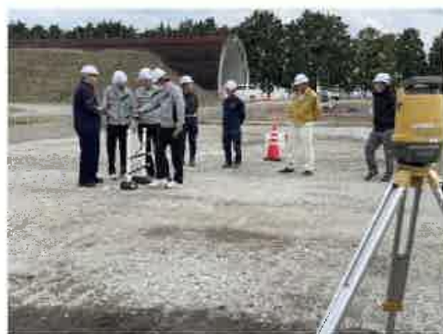
TSを用いた位置出しからの丁張
