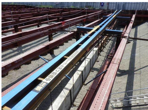
⑦吊防護（東電埋設管の保護）
