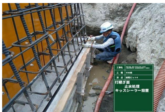
①NETIS登録商品によるコンクリート打ち継ぎ目での漏水防止対策
