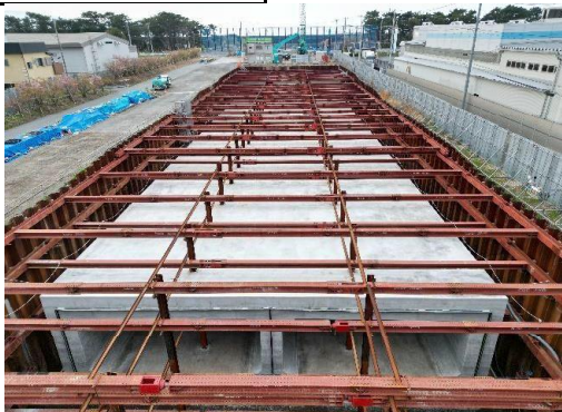
①完成写真（コンクリート出来栄え）
