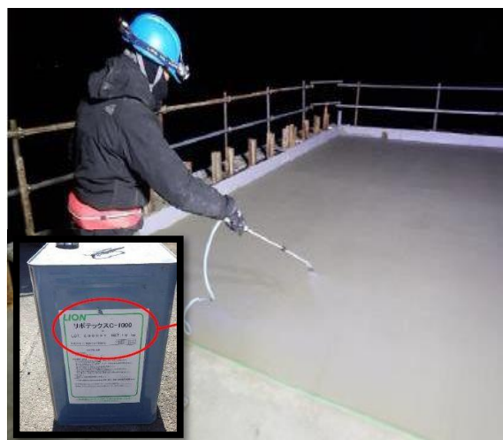
③コンクリートの養生に関する工夫
