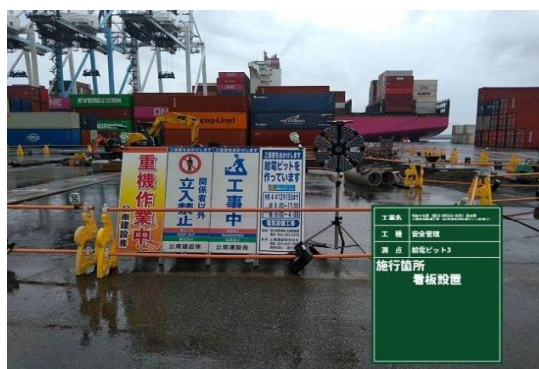
④工事看板、バリケードの設置
