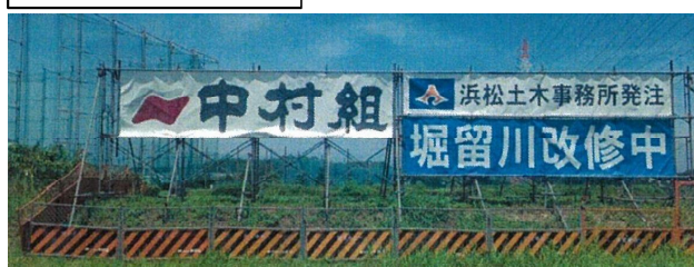
③大型掲示板設置
