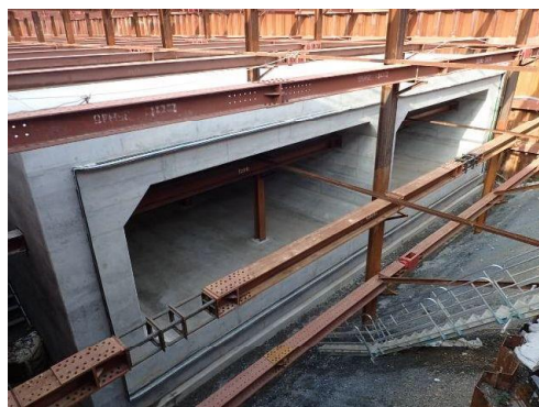
②完成写真（コンクリート出来栄え）
