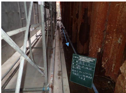
⑤見切壁による仮排水路
