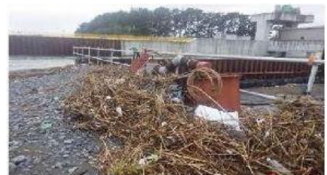
台風1号(R4.4.15)による仮締切内浸水
