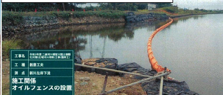
② オイルフェンスによる河川への油流出対策
