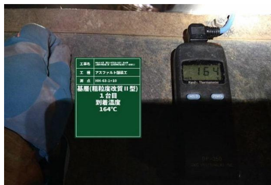
③適切な温度で合材打設
