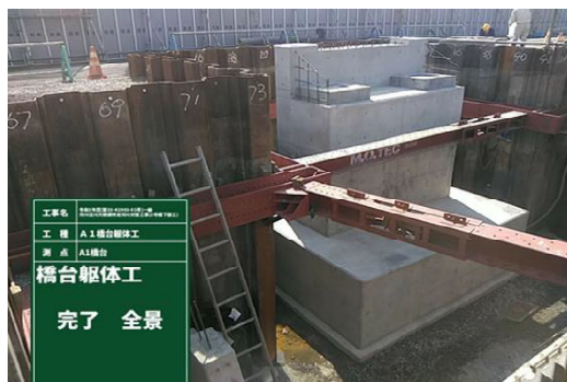
④ 橋台完成
