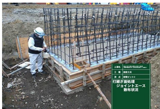
①NETIS登録商品によるコンクリート打ち継ぎ目での漏水防止対策
