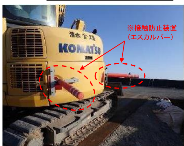
④作業用重機の接触防止対策
