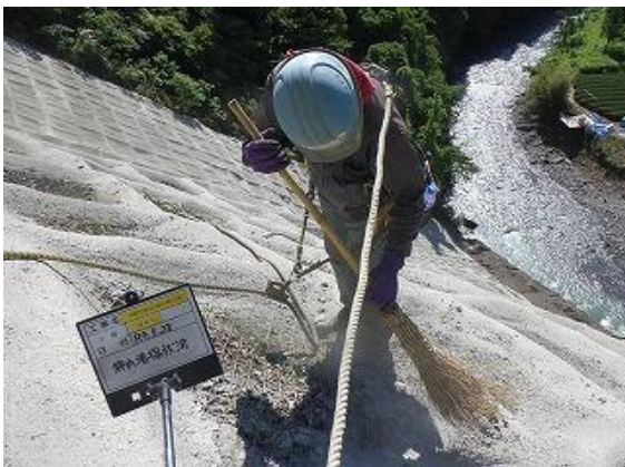
安全対策（平均傾斜45度の急傾斜地におけるライフライン着用による作業状況）
