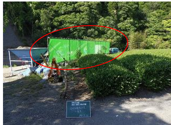
資機材の飛散防止対策の実施 （景観に配慮し緑色のシートを使用）
