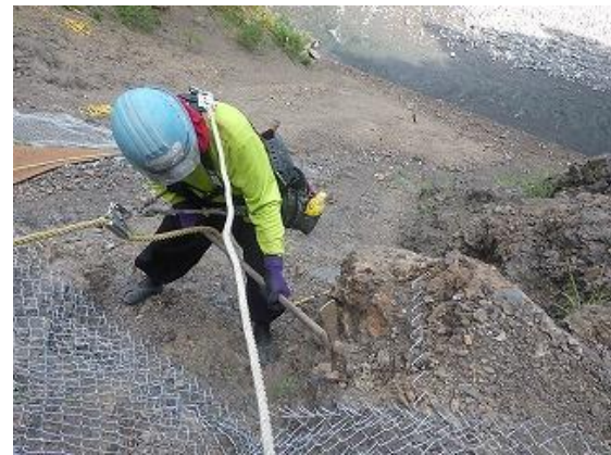
安全対策（平均傾斜45度の急傾斜地におけるライフライン着用による作業状況）
