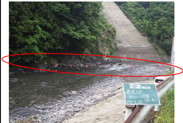
安全対策 （施工地への第三者の進入防止ロープを設
