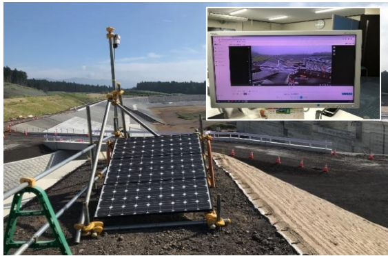
ソーラー充電式webカメラ・遠隔現場確認
