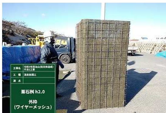
創意工夫 (流末処理工のワイヤメッシュ外枠の作成)
