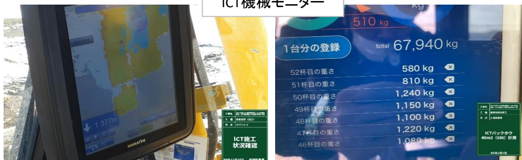
ICT機械モニター
