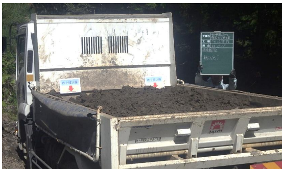
【地域貢献】環境保全 (搬出土砂による道路の防塵対策のための土砂運搬トラックの過積載防止の工夫)
