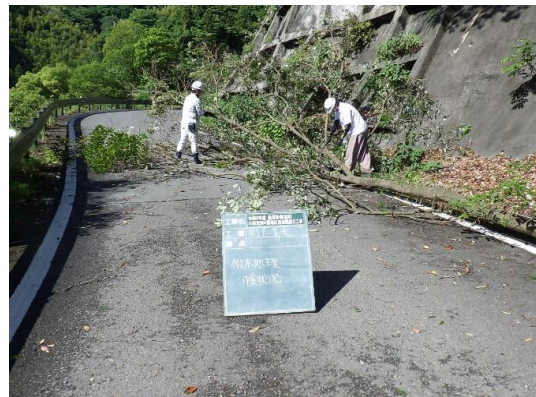
大雨後の現場周辺部の倒木処理
