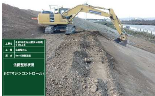
ICT技術の活用 (3次元マシンコントロールBHの導入)
