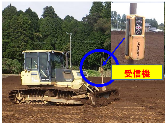
レーザーレベルの使用
