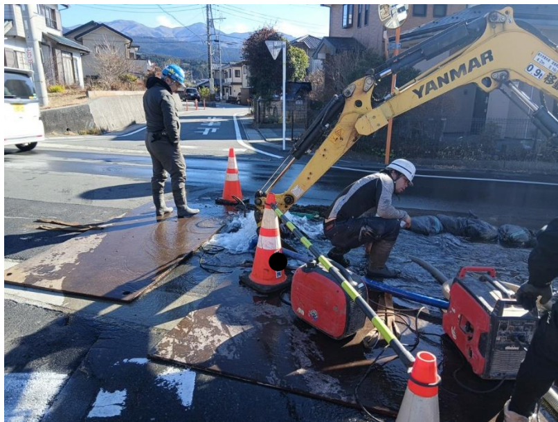
破損した給水管
