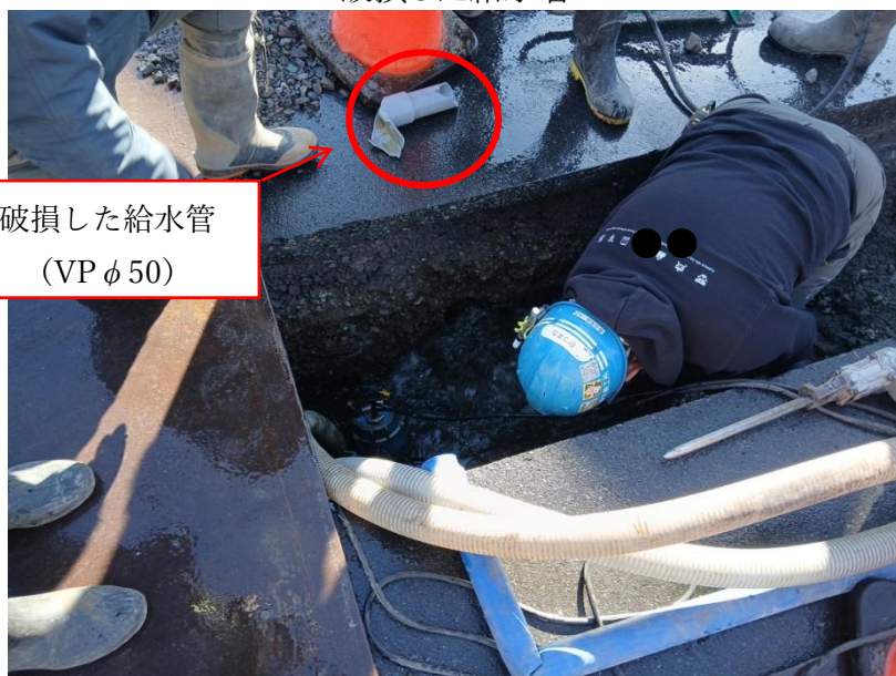
破損した給水管
