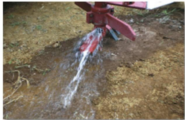
横方向にスラリーが吐出し、樋(H)をつたってコラム外周端まで届き、全体に均一なコラムを形成することができる。
