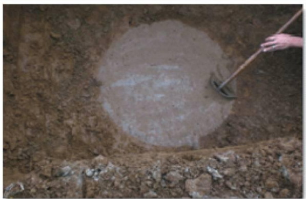
攪拌ムラがなく、土塊が残らず、均一な仕上がり。
