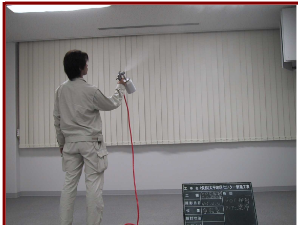
SODリキッド塗布状況
