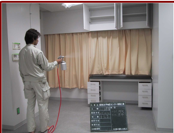
SODリキッド塗布状況
