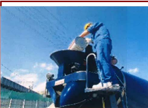
アドミックスの投入攪拌(現場練り)
