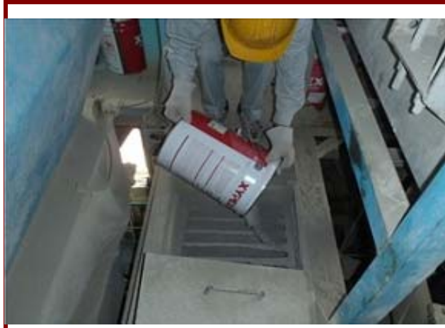
アドミックスの混和(ハッチャープラント)
