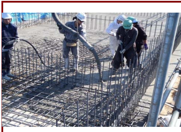
アドミックス混和コンクリートの打設
