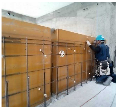
②型枠組立ての様子
