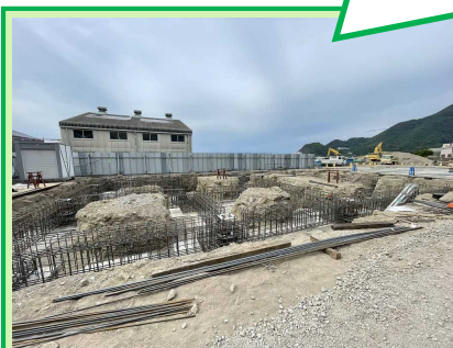
根切り・鉄筋工事
