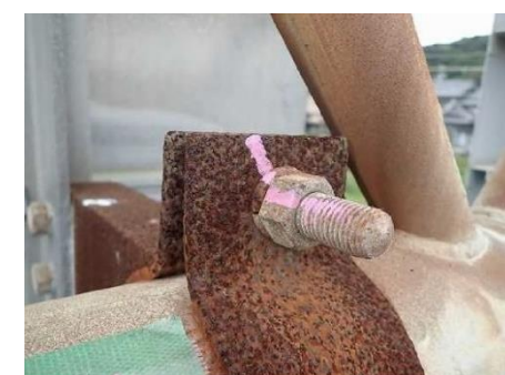
写真-7.6 ボルトのゆるみ
