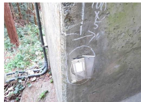
写真-7.4 反射材の変形
