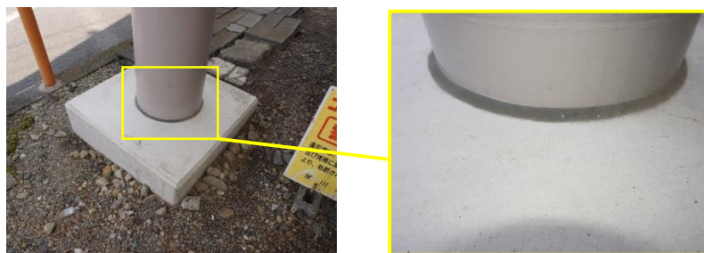
図-7.3 柱基部のシーリング
