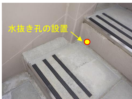
図-7.1 水抜き孔の設置
