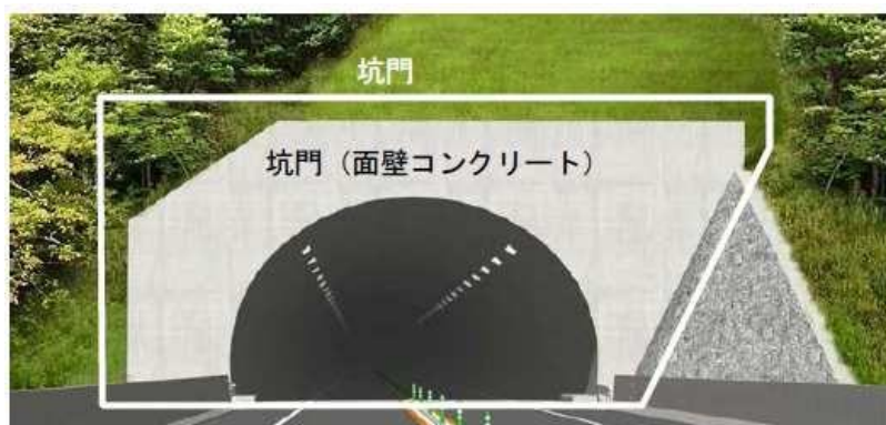
図 1.2 点検対象箇所（トンネル坑口部） 1)
