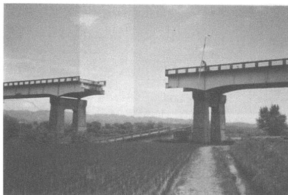
図 8-27 ゲルバー橋吊桁の落下
