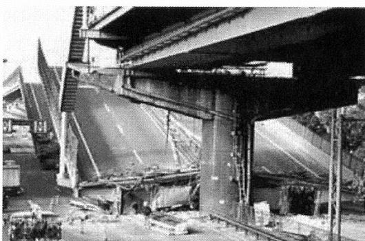
(c) シナリオ C：桁が橋軸方向へ変位した例
