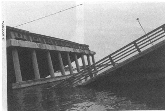
図 8-30 地盤の流動化による下部構造の大変位と単純桁の落橋（落橋防止装置未整備）
