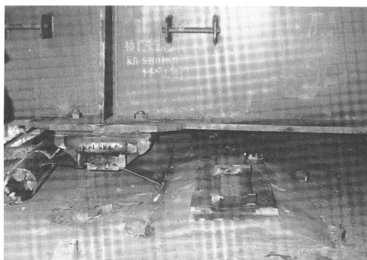
図 8-22 ローラー支承の破損
