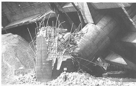
図 8-2 段落し部の損傷による倒壊
