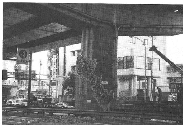
図 8-4 段落し部を起点とするせん断破壊
