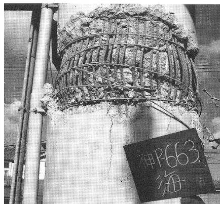
図 8-3 段落し部の曲げせん断損傷
