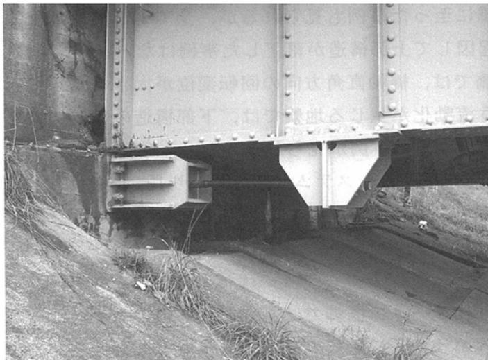
図 8-37 平成 15 年宮城県北部地震において落橋防止構造による変位拘束効果が検証された事例
