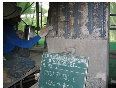
鉄筋防錆工
