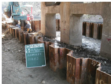
矢板打込み完了
