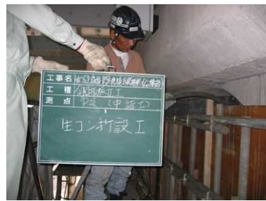
コンクリート打設工
