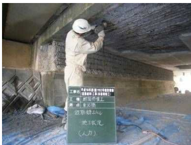
鉄筋錆落工
