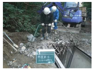
コンクリートはつり工
