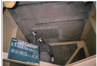
鉄筋錆落工
