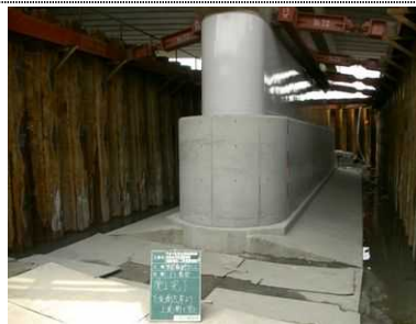
根巻きコンクリート工
