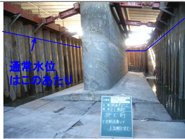
既設躯体状況
