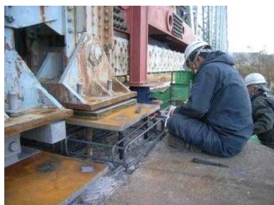
鉄筋組立て工
