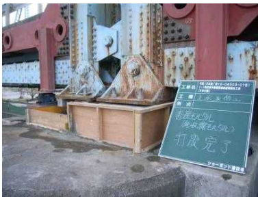
モルタル打設工
