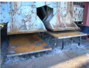
ベースプレート設置
