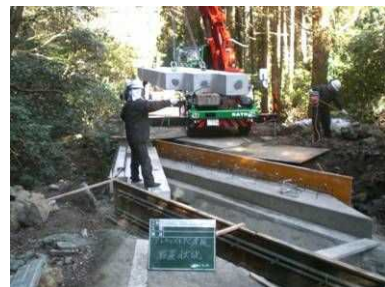
プレキャストPC床版設置工
