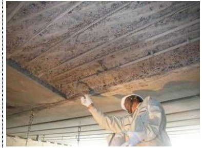
鉄筋防錆工
