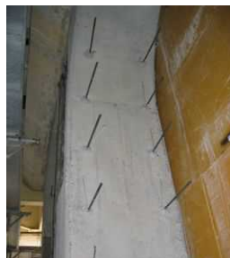
ずれ止めアンカー工
