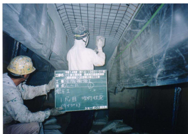
増厚（吹付け工）
