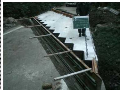
エラストイト貼付工
