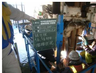
鋼矢板溶接状況
