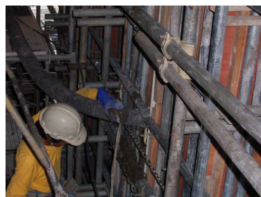
コンクリート打設工
