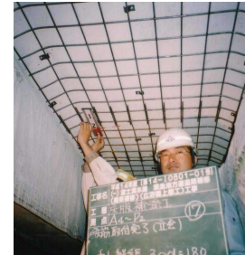
鉄筋取付工
