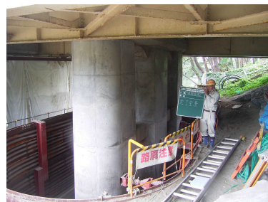
RC巻立て工
