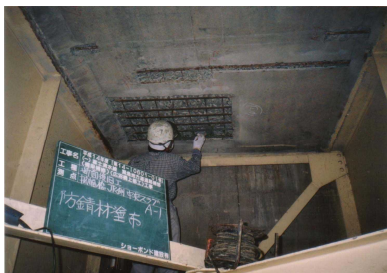
鉄筋防錆工
