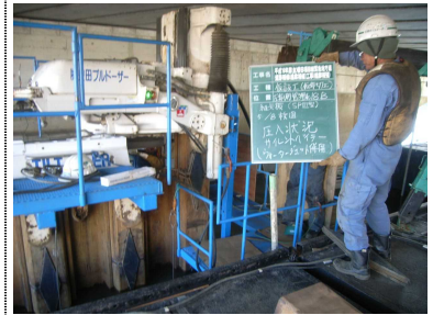
鋼矢板圧入状況
