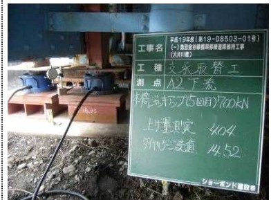
ジャッキアップ
