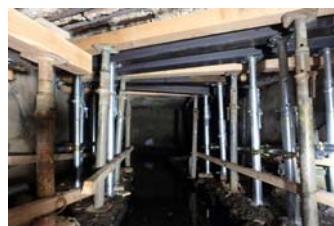
（支保工の設置）
