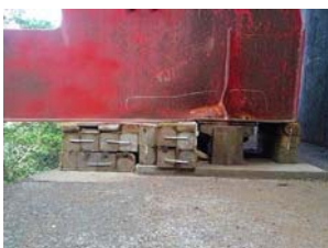
（仮受けの設置）
