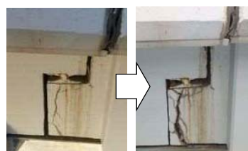
（定点写真撮影による変状調査）
