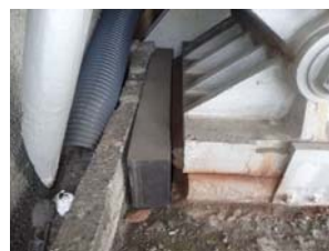
（支承ローラー脱落防止）
