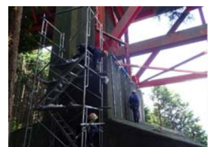
（近接目視のための階段設置）
