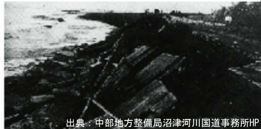
長さ200メートルにわたって崩壊した海岸堤防（富士市三四軒屋地先）
