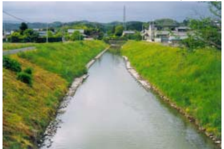
垂木川(新橋付近)
