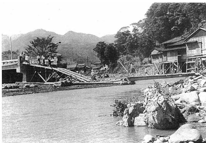
図-2.1 昭和33年 狩野川台風による被害状況（流失した留田橋左岸）
