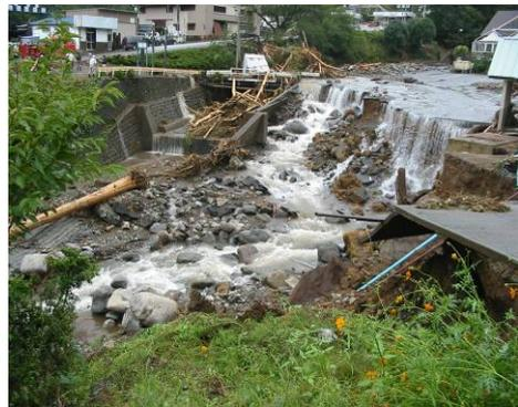
図-2.5 烏川護岸崩壊状況
