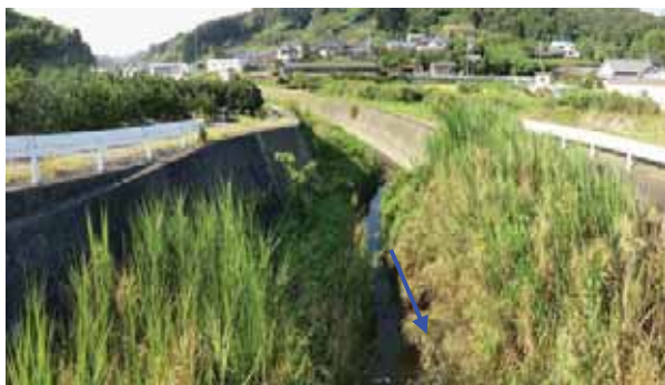
上流部の状況（河口から 9.30km 付近）
