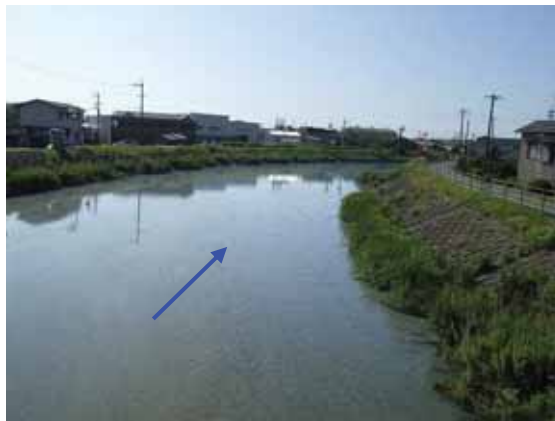
下流部の状況（井上橋より下流側：河口から 2.0km 付近）
