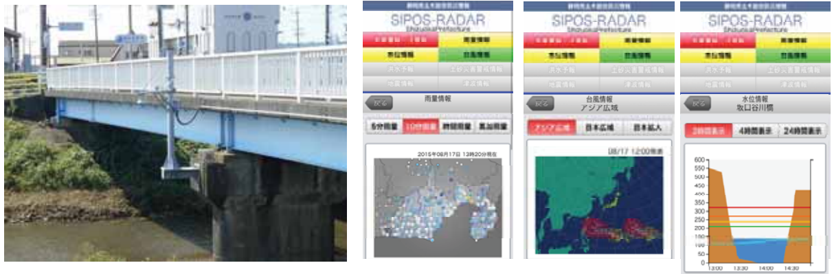
坂口谷川橋水位観測所
