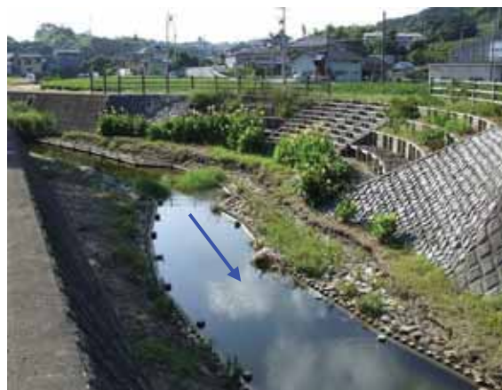
上流部の状況（河口から 8.85km 付近）
