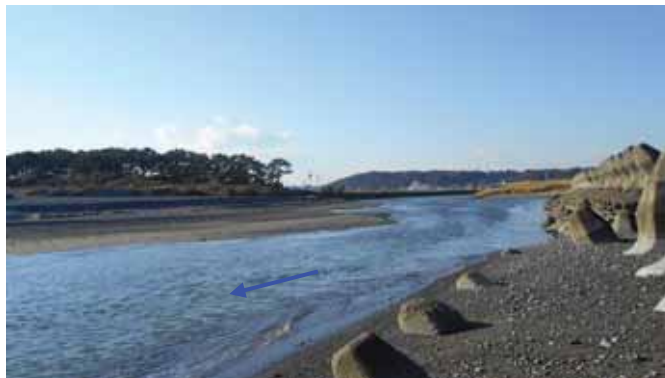
下流部の状況（河口部より0.1km付近）
