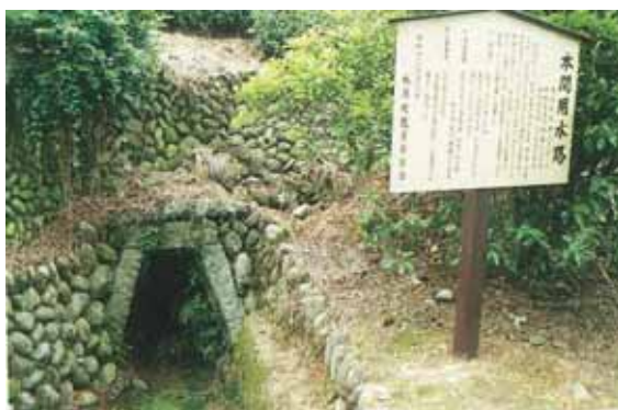
本間 ずいどう 隧道出口と案内看板
