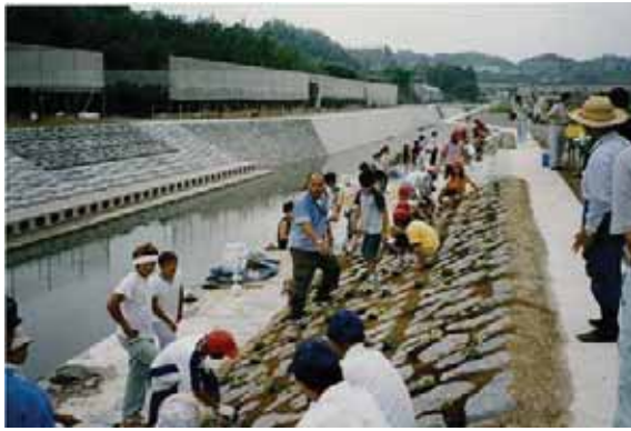
堂ヶ谷橋上流親水護岸整備
