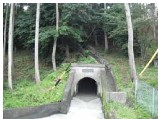
現在の用水路（榛原 ずいどう 幹線隧道出口）
