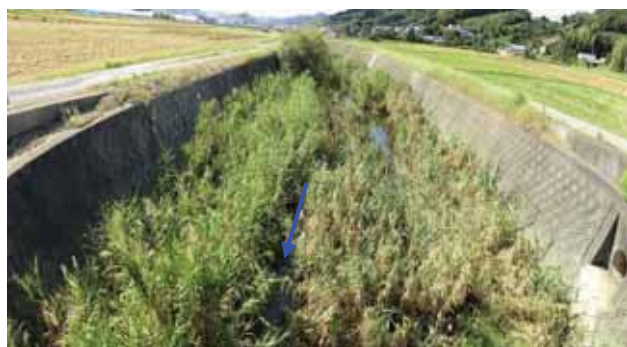
中流部の状況（山脇橋より上流：河口から 6.7km 付近）
