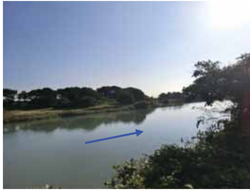
下流部の状況（河口部より0.4km付近）
