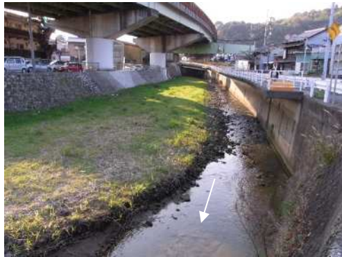
河川側に張り出している歩道の様子
