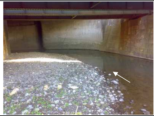
JR 東海道本線横断部の屈曲部の様子
