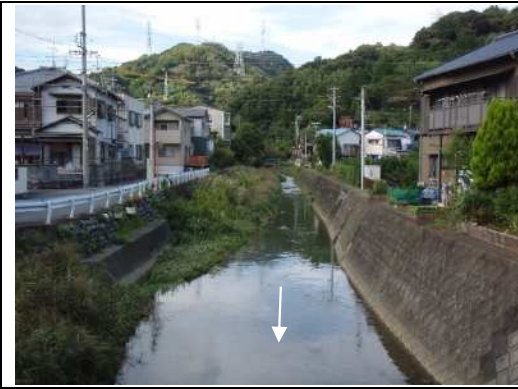
一次改修済の下流部の状況
