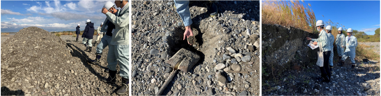
天竜川の掘削予定箇所の土質等確認（令和5年11月）
