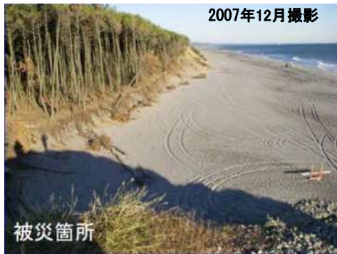
2007年7月の台風第4号による堤防(土堤)の侵食状況
