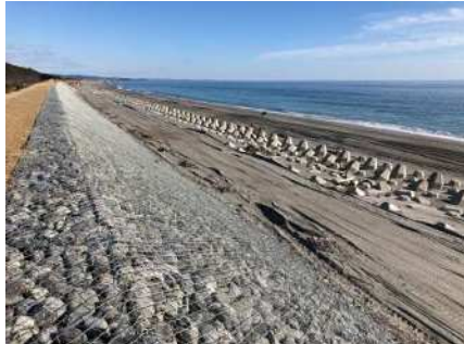
③6号離岸堤下手
