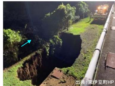
図44: 白田浄水場の被災状況（護岸被災）
