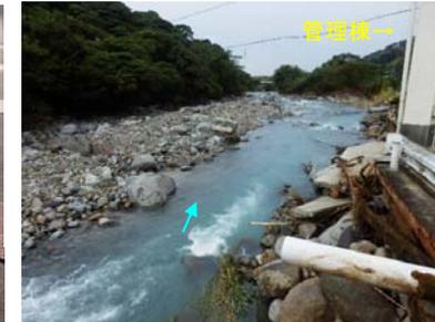
図45: 白田取水場の被災状況（管理棟基部護岸流出、取水工破損）
