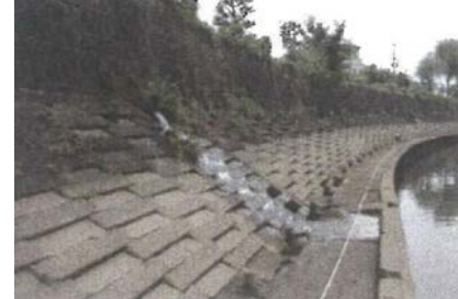
①コンクリート矢板部の被害 (新小坂川橋上流) ②ブロック張部の被害 (新小坂川橋下流) ③ブロック積部の被害 (河口~新小坂川橋間)
