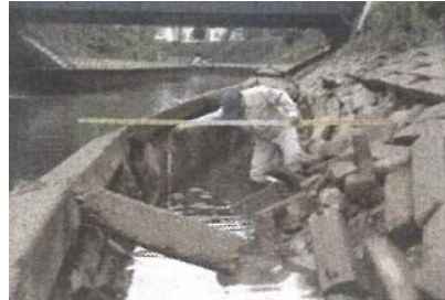
①コンクリート矢板部の被害 (新小坂川橋上流) ②ブロック張部の被害 (新小坂川橋下流) ③ブロック積部の被害 (河口~新小坂川橋間)
