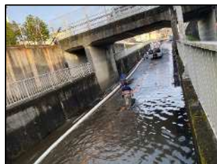
中港地下道 排水作業
