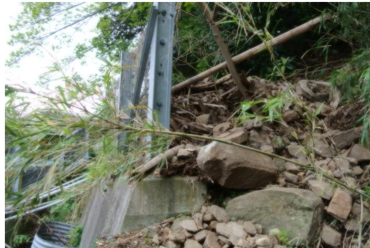
がけ崩れ発生直後 (H29.4.21)
