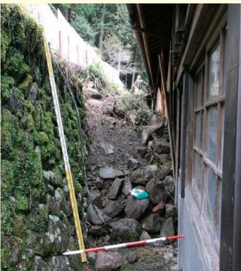
人家裏のがけ崩れ状況(静岡市葵区梅ヶ島地内)
