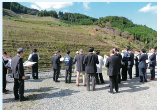
「星野川(砂防)」工事現場にて
