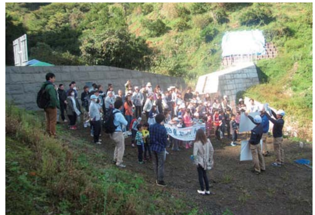
山ノ神川砂防堰堤お披露目会(静岡土木事務所：静岡市清水区)
