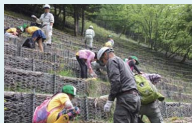
植樹作業の状況
