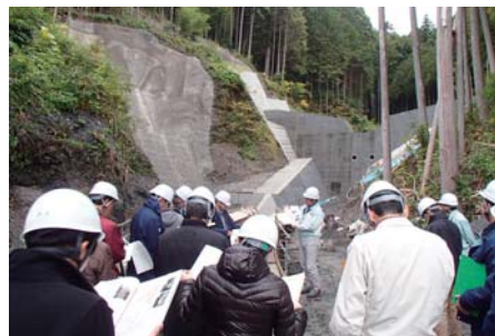
現場研修の様子(丹谷沢砂防堰堤)
