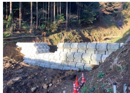
仮設ブロック堰堤の設置状況(富士砂防事務所提供)
