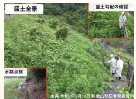
盛土総点検実施状況
