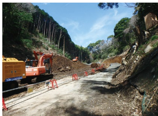
新設砂防堰堤の施工箇所(4月6日撮影)
