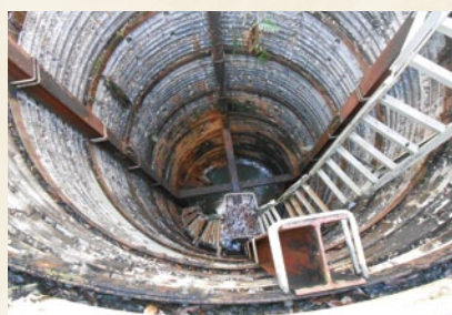
集水井内部(径3.5m、深さ15m)
