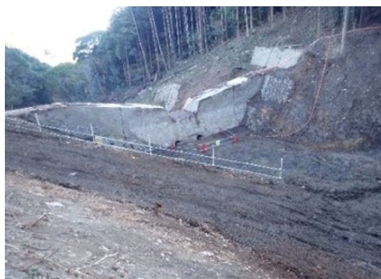
既設砂防堰堤除石完了(富士砂防事務所提供)
