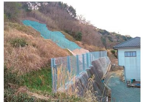
宮田No2急傾斜地崩壊対策施設(R4災害復旧工事)
