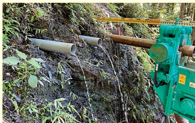
応急横ボーリング工の施工状況
