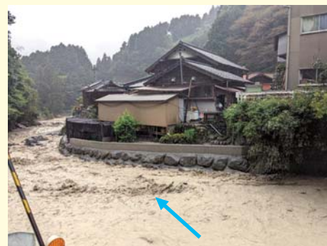
諸子沢川土砂流出状況
