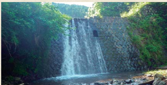
湯船潭砂防堰堤(小山町:昭和10年竣工)
