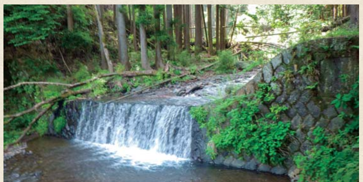
湯船澤下流砂防堰堤(小山町:昭和5年竣工)
