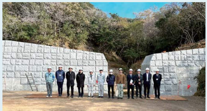
砂防堰堤施工中の三堂川(西伊豆町)の現場視察
