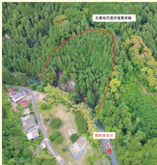
長沢地すべり全景
