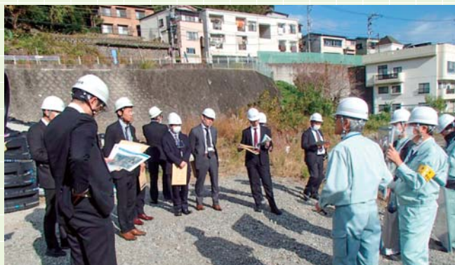
逢初川現場視察
