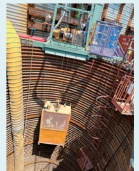
深礎杭工内部の見学
